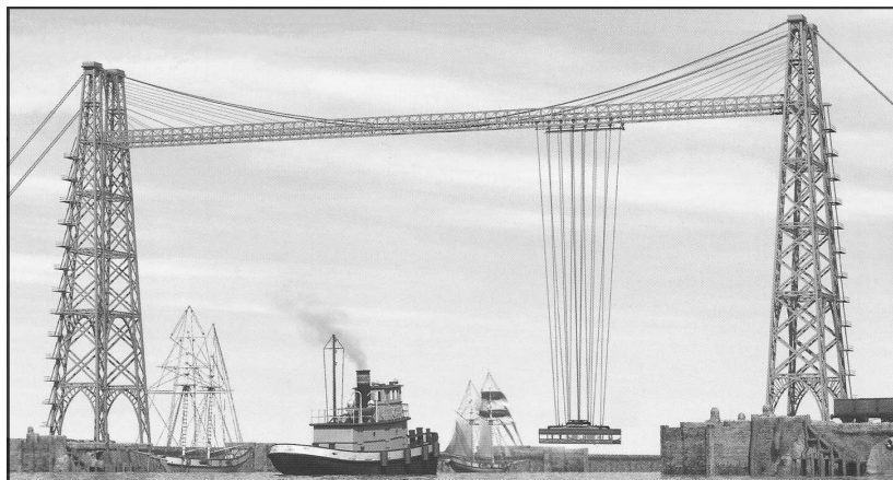
Pont transbordeur - Rouen Structure métallique Nacelle suspendue
